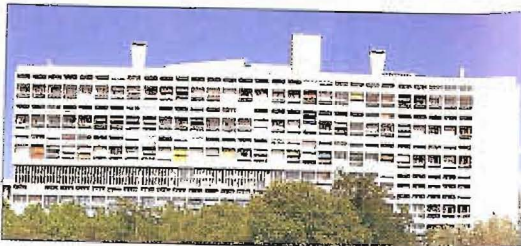
La Cité radieuse, construite par Le Corbusier, à Marseille
